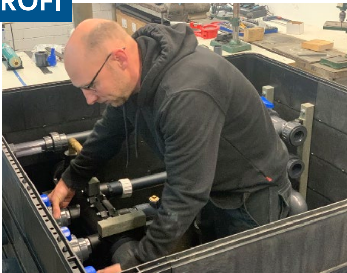
Steht öfters in der Kiste und wird gerne auch „Kai“ gerufen: Reno Hottenbach, Spezialist für den Bau von Technikschrächten.
