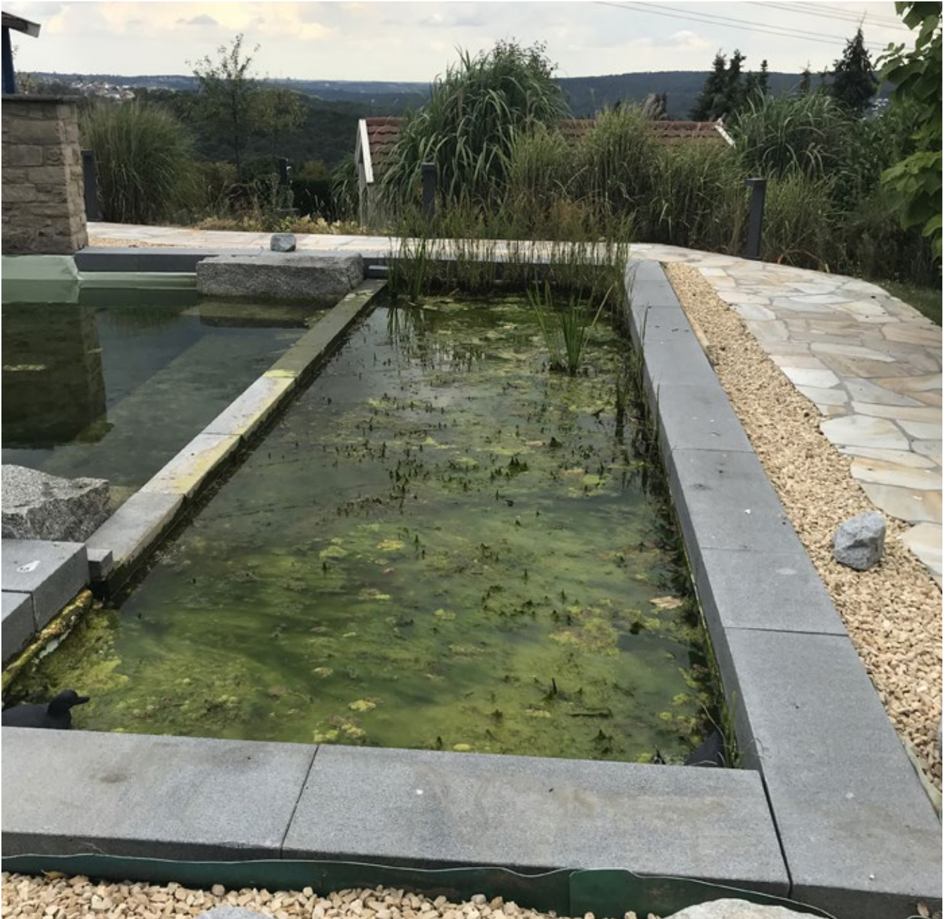
▲ Wenn das Zuschütten die scheinbar einzige Alternative zu solch einem Anblick ist, kann es hilfreich sein, den Blick über die Grenzen eines traditionellen Schwimmteiches hinaus zu richten.
