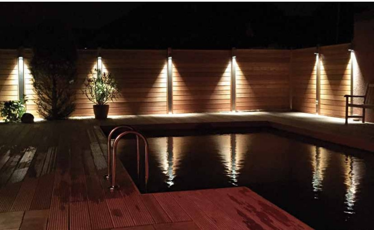
▼ Moderne Lichttechnik kann voll vernetzt zu ausgeklügelten Systemen verbunden werden. Professionelle Planung und Installation schaffen die gewünschte Ästhetik, die nötige Sicherheit und ein angemessenes Energiemanagement.
