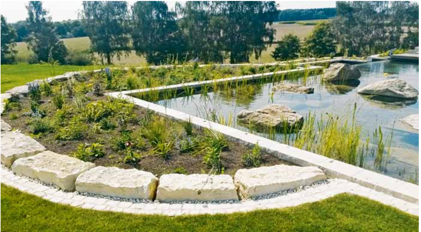
▲ Der Naturpool ist an erhöhter Position gebaut. Oberflächenwasser hat keine Chance. Gegen zu viel Eintrag von natürlichem Nachfüllwasser sichert ein groß dimensionierter Notüberlauf den Naturpool. Dieser fügt sich harmonisch in die Randgestaltung ein und bringt optisch eine Stufe ins Spiel.
