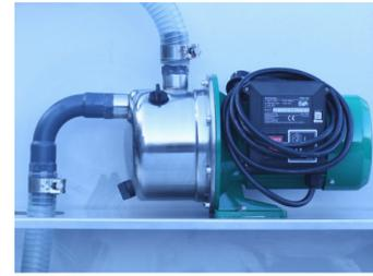
Die Hochdruck-Spülpumpe wird wartungsfreundlich außerhalb der Filterkammer auf einem Geräteträger aufgebaut.
